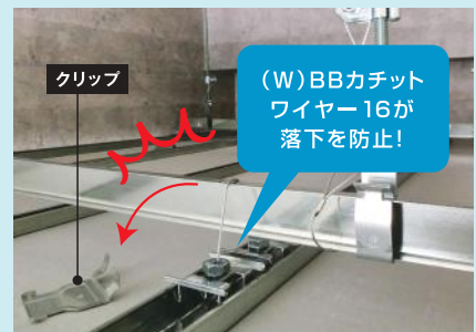
クリップ損傷時
